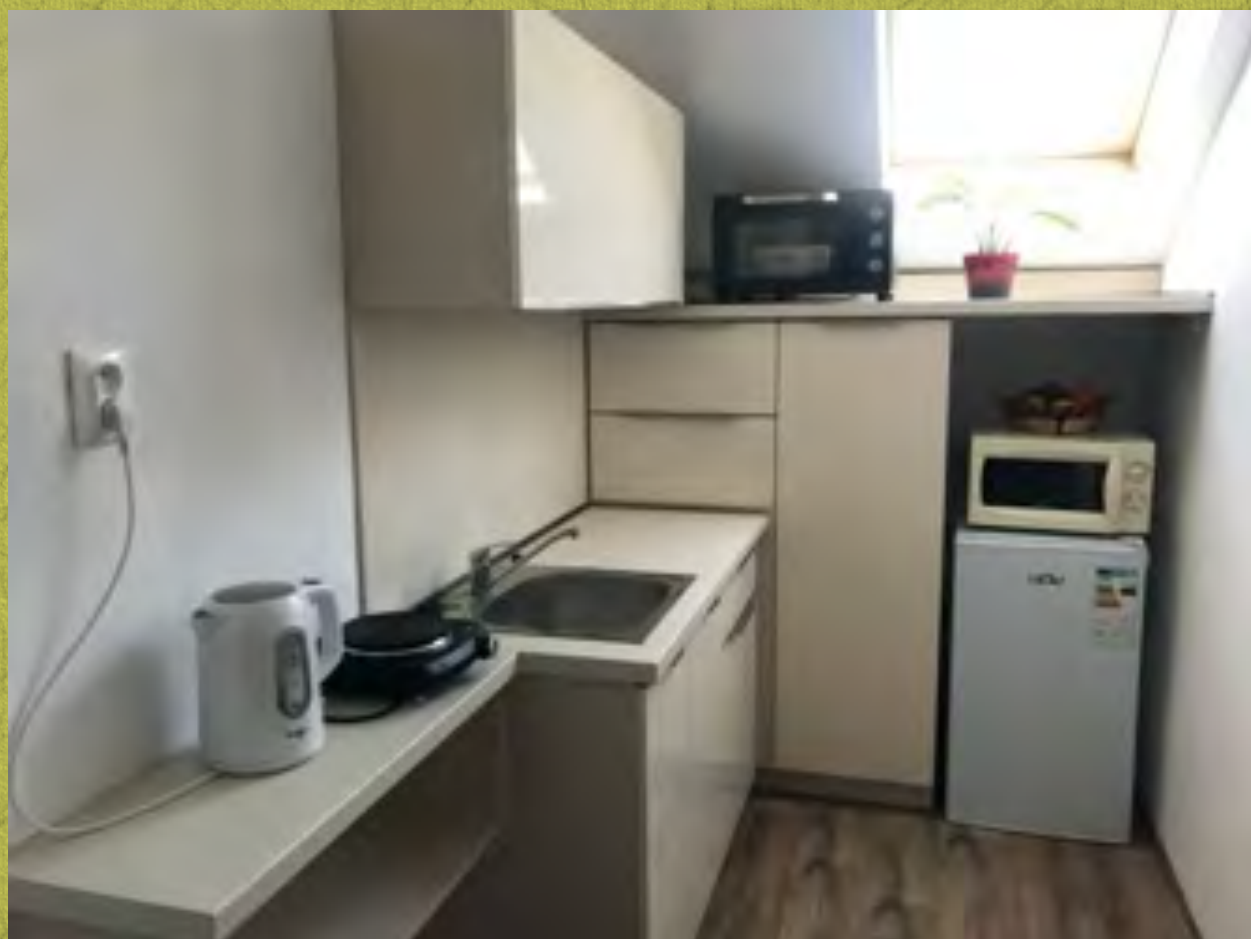
Výmena kuchynskej linky a spotrebičov v podkroví
