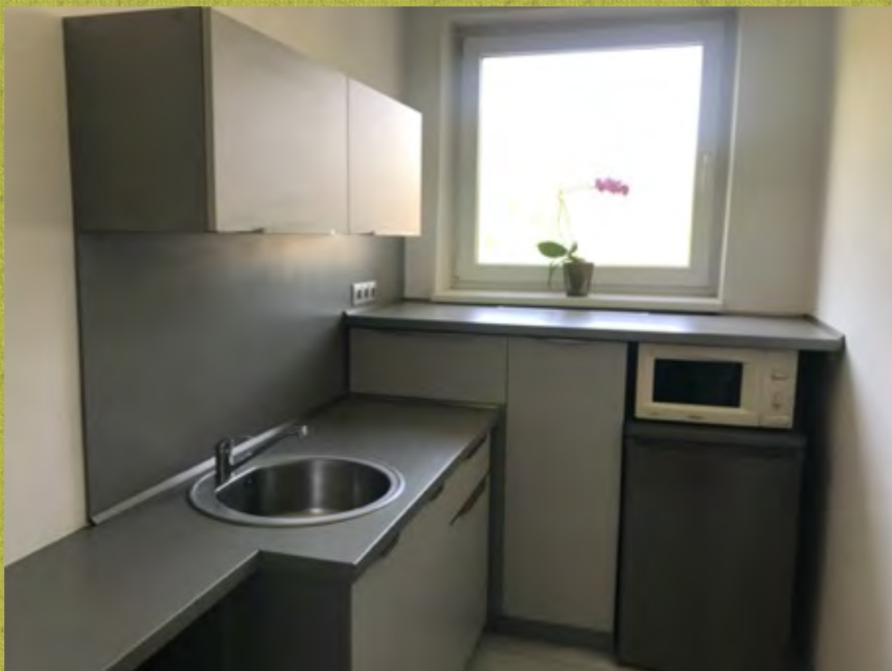
Výmena kuchynskej linky a spotrebičov na prvom podlaží.
